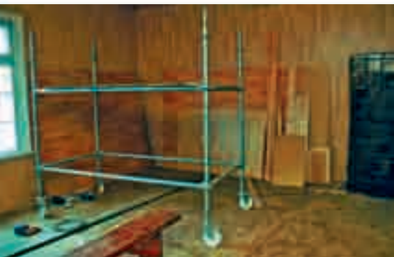
Remontuojama bendruomenės namų salė
