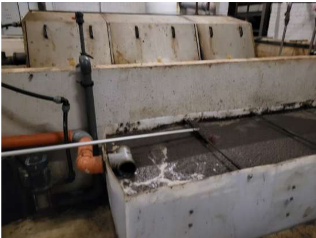
3.6 pav. Būgninio filtro praplovimo vandens surinkimo talpa su surinktais riebalais
