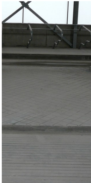
15 pav. Galvijų vaikščiojimo takų betoninės grindys su grioveliais
