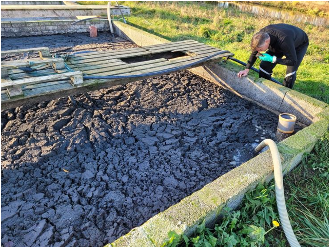
3.10 pav. Sėsdintuve surinktas būgninio filtro praplovimo vanduo, paveiktas koaguliantų
